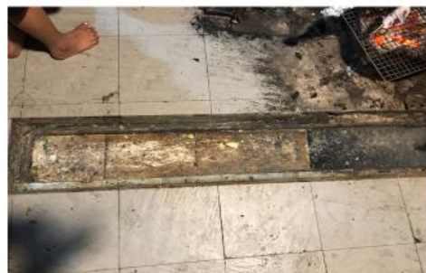
厨房の側溝の様子
